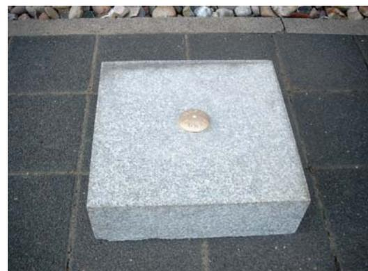
(j) LGN-Grundnetzplatte mit Höhenbolzen
